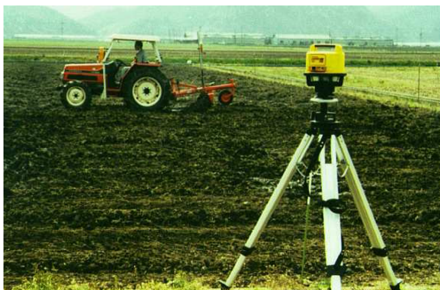
写真Ⅱ-5-8 レーザー利用の均平作業
